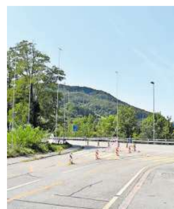
Die Einmündung der Gartenstrasse in die Schaffhauserstrasse sollte verschmälert werden. Bild: Nadine Böni
